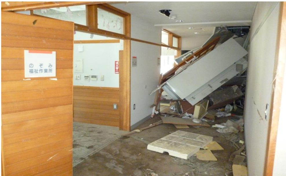
△旧福祉作業所のぞみ内部
